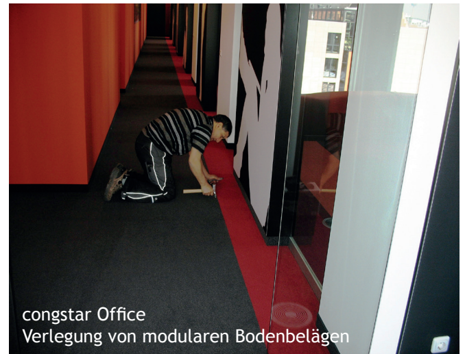
congstar Office Verlegung von modularen Bodenbelägen
