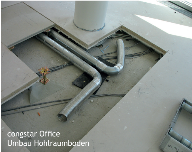
congstar Office Verlegung von modularen Bodenbelägen
